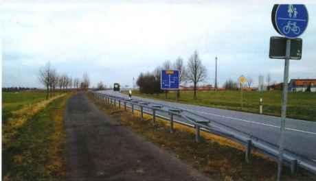
Die Planung der Nord-Süd-Verbindung umfasst den dreistreifigen Neubau als Lückenschluss zwischen der BAB 4 AS Weißenberg und dem Anschluss an die B 178n bei Nostitz auf einer Länge von ca. 5,5 km
